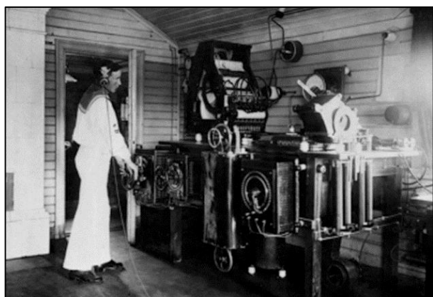
Interiör från radiostationen som visar den tyska gnistsändare som installerades 1911. Personen på bilden är Gunnar Ljungkrantz, bild från 1917. (Foto FHT)
